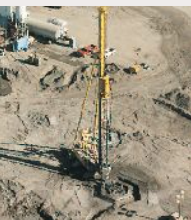
同、SMWグリッド施工状況
