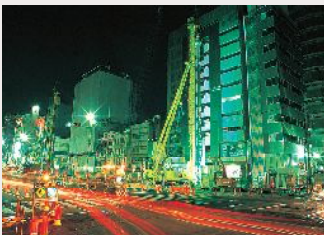
長堀地下駐車場・大阪市営地下鉄7号線、山留め壁
