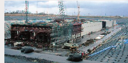
新潟みなとトンネル、沈埋函のドライドック山留め壁
