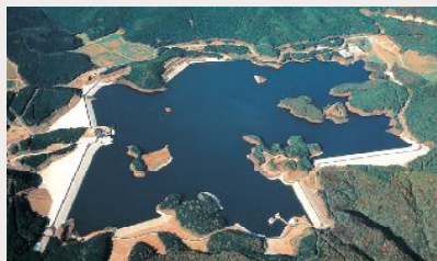
大河内水力発電所太田ダム、止水壁
