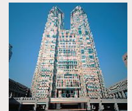
新東京都本庁舎、山留め壁
