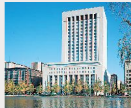
DNタワー21 第一・農中ビル (東京)、山留め壁
