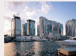
天王州アイランドシティ 駁船ビル、山留め壁
