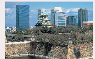
大阪ビジネスパーク、山留め壁
