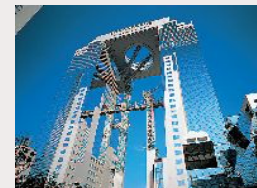
梅田スカイビル、山留め壁
