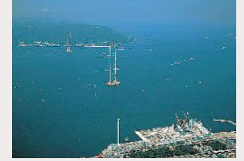
明石海峡大橋アンカレッジ、RC連壁のSMWガイドウォール
