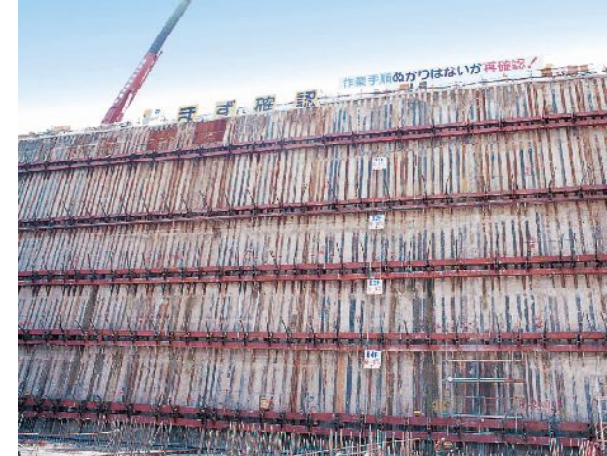
H鋼フランジ面までつった掘削完了時の壁面
