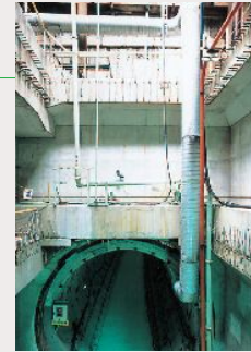
JR東西線、大川シールド発進立坑、山留め壁
